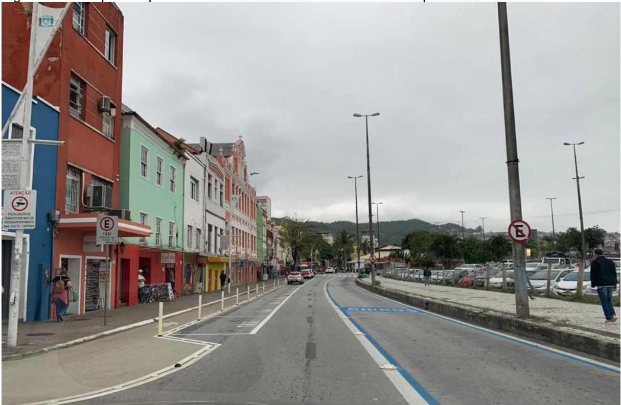
Figura 105 - Requalificação de rua consolidada no Centro de Florianópolis/SC
