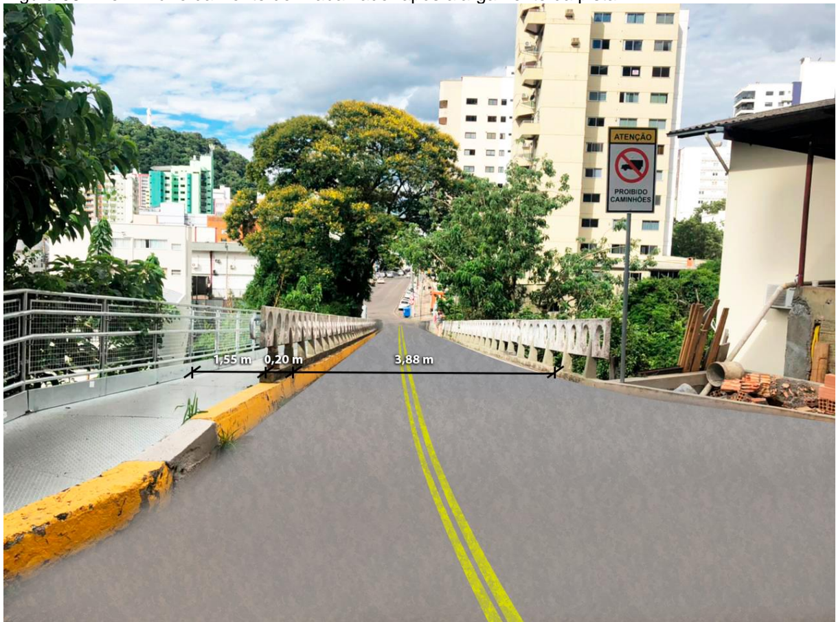
Figura 98 - Perfil viário da Ponte do Trabalhador após alargamento da pista
