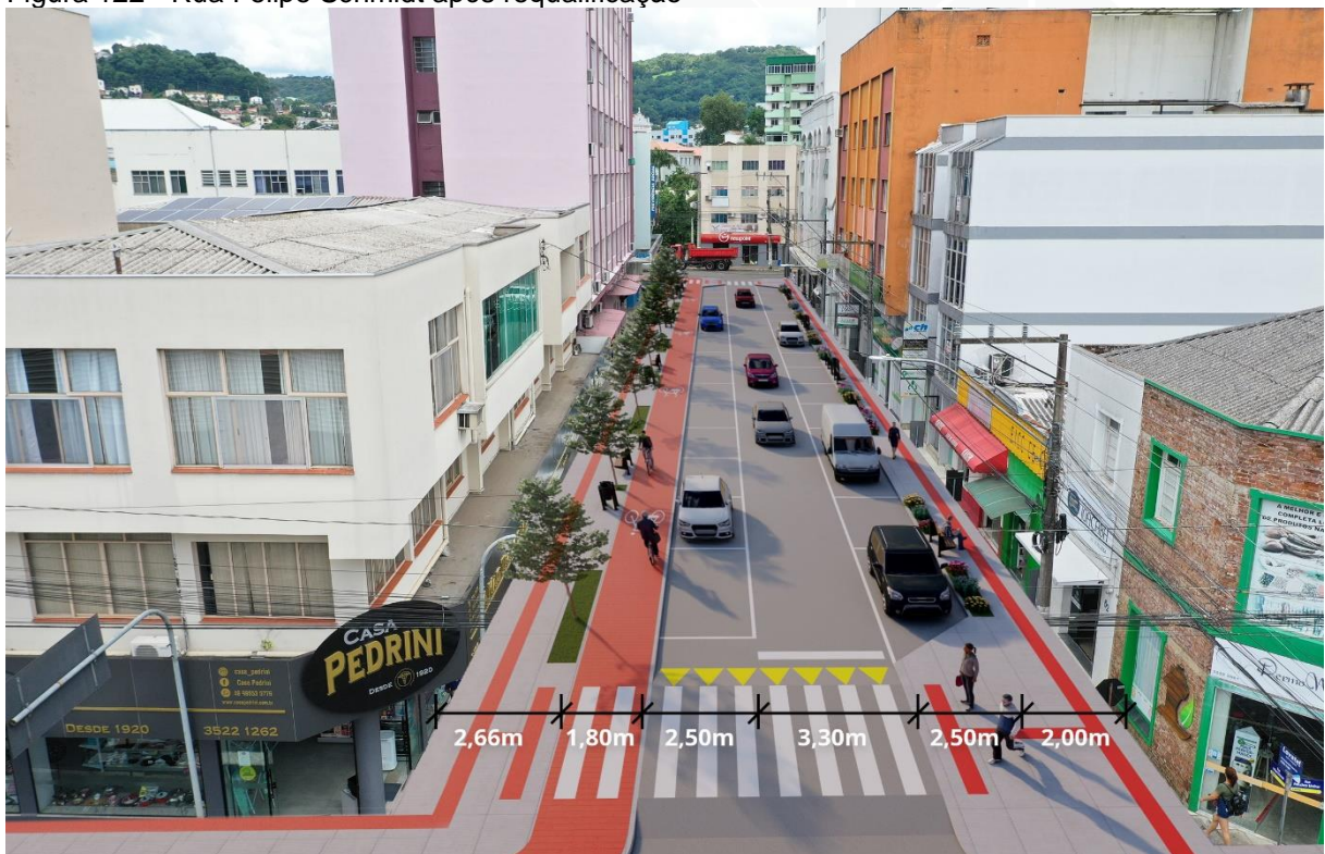
Figura 122 - Rua Felipe Schmidt após requalificação
