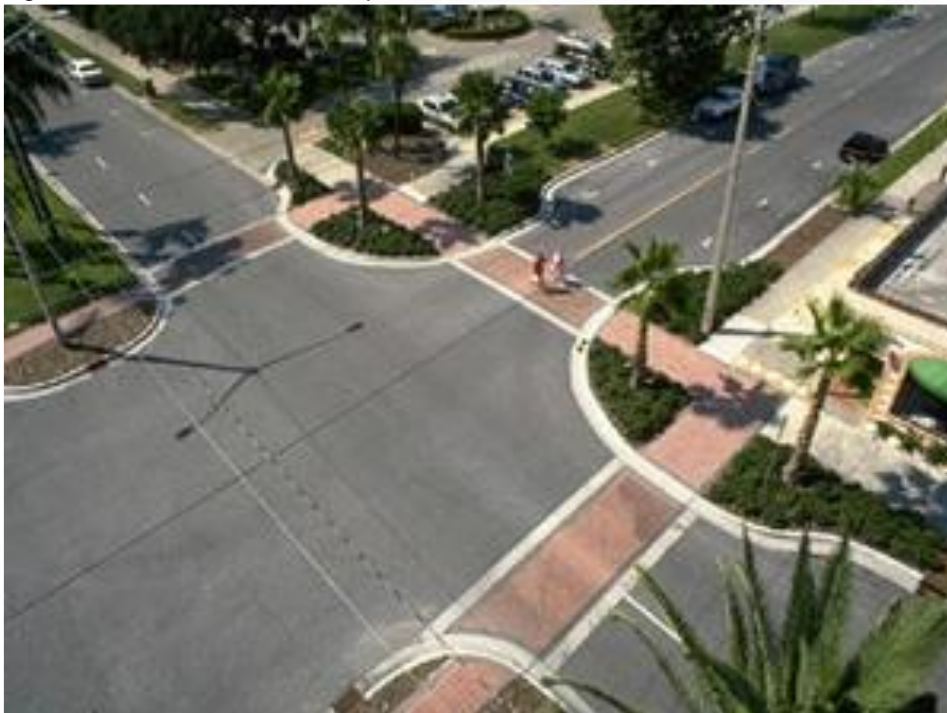
Figura 110 – Estreitamento de pista
