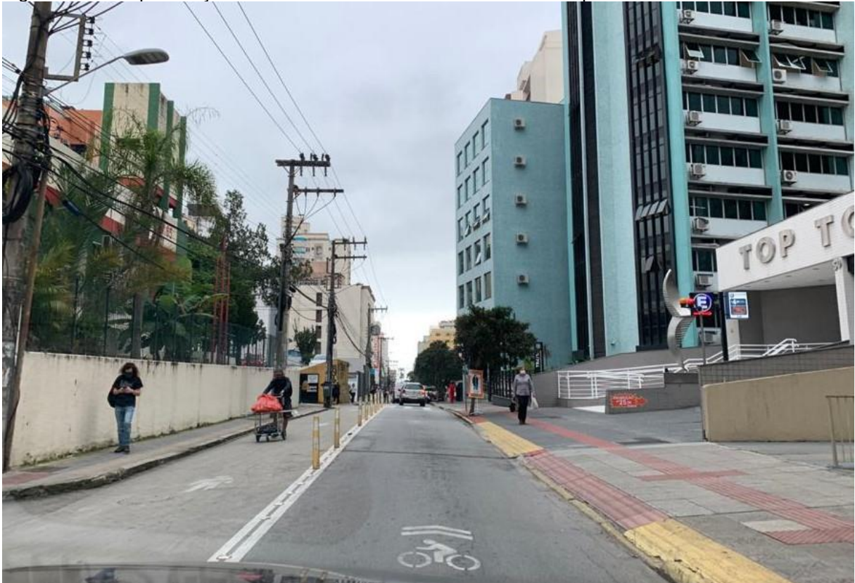
Figura 104 - Requalificação de rua consolidada no Centro de Florianópolis/SC
